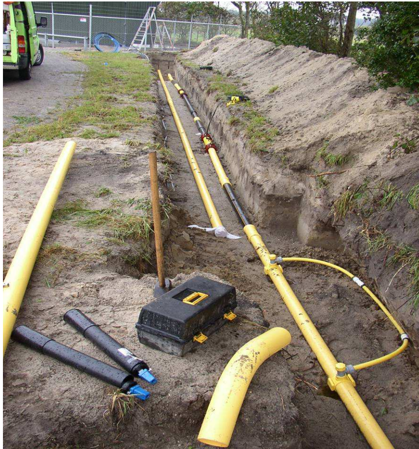
Figuur 4: Aanleg referentienet door Joulz
