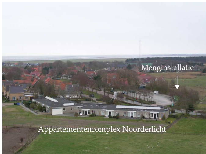
Figuur 1: De menginstallatie en appartementencomplex 'Noorderlicht' in Nes op Ameland
